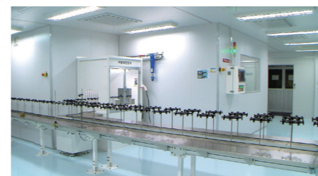
クリーンルーム 参考写真
